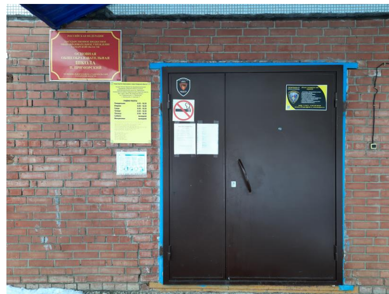
Фото № 4 Входная дверь
