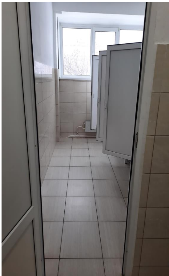
Фото № 17 Двери туалетной комнаты
