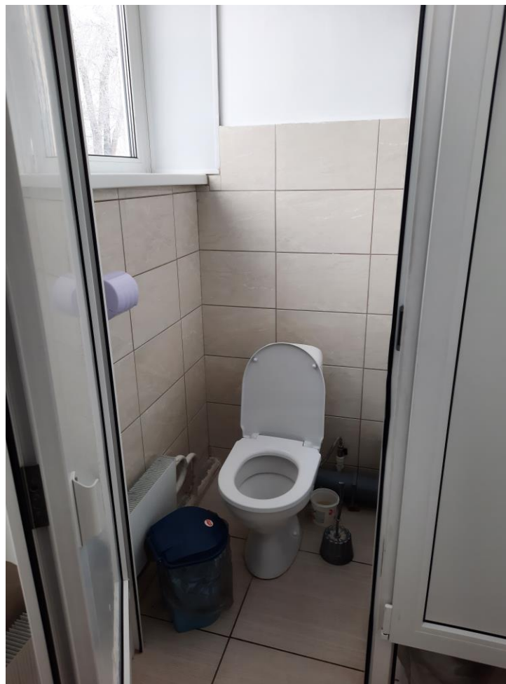
Фото № 16 Унитаз в туалетной комнате
