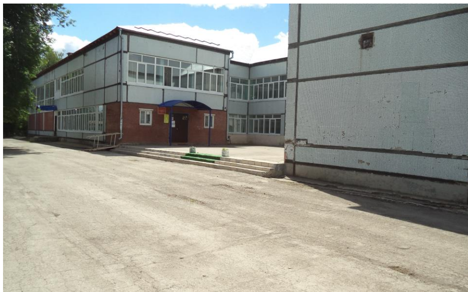
Фото № 3 Входная площадка.
