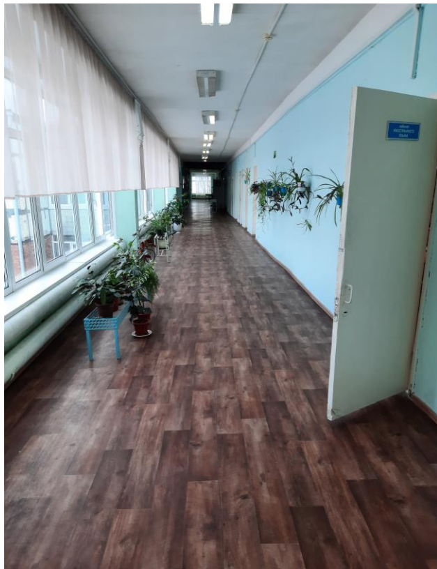
Фото № 7 а Коридор второго этажа
