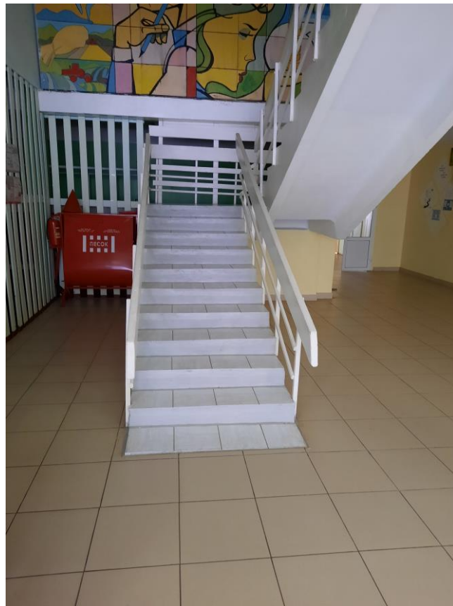
Фото № 9 Вход на лестницу
