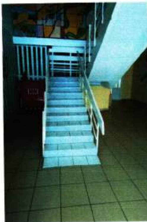
Фото № 9 Вход на лестницу
