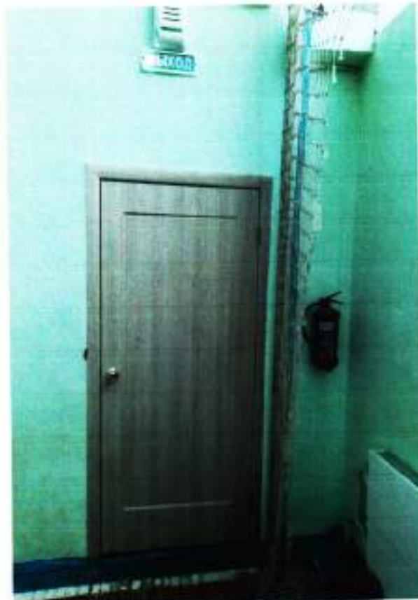
Фото № 12 Эвакуационный выход
